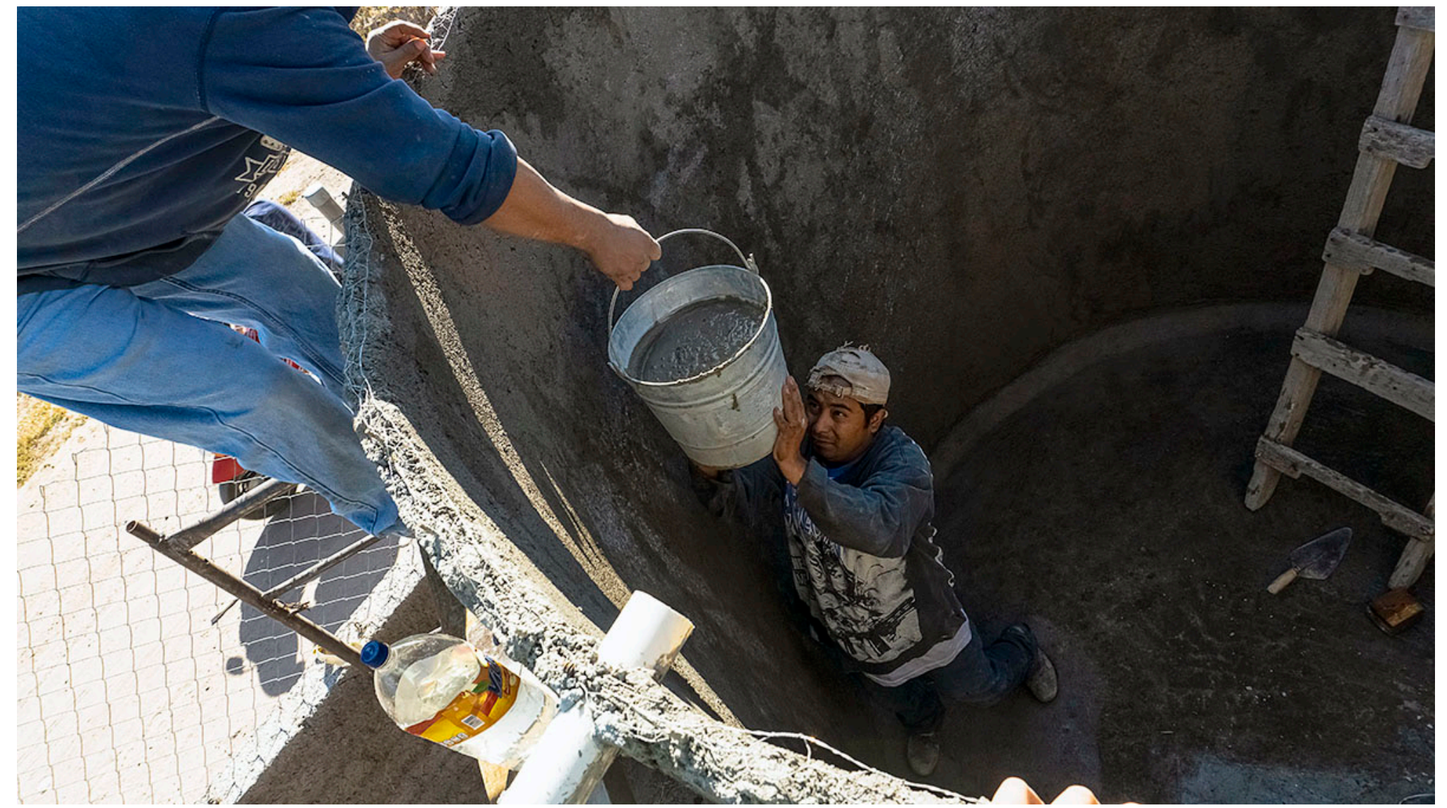
Foto: Dos miembros de una comunidad trabajando en la construcción de un sistema de recolección de agua de lluvia.
