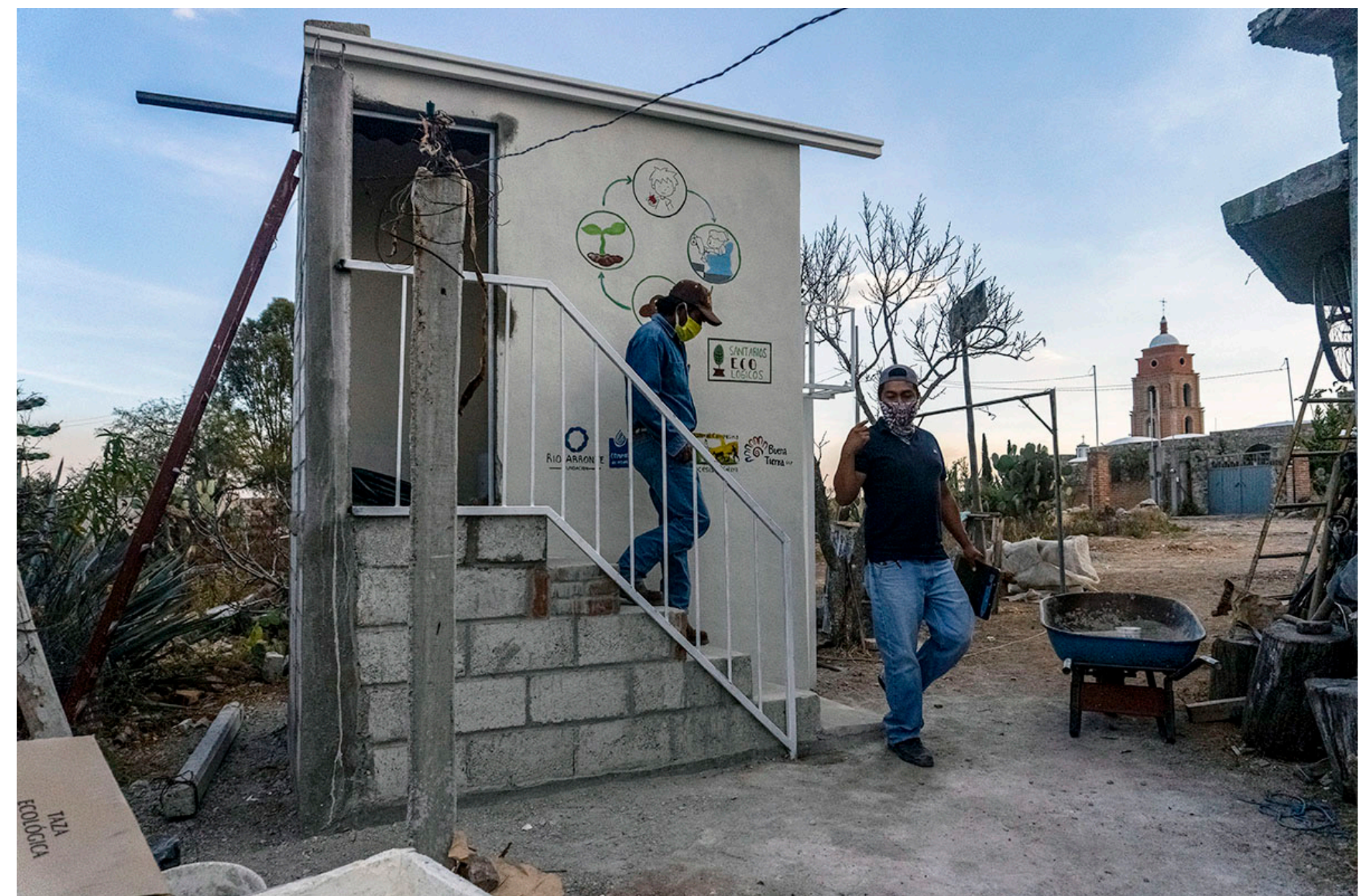
Foto: Saúl inspeccionando la construcción de un baño seco en la comunidad de San Cayetano.
